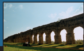
PARCO DEGLI ACQUEDOTTI
